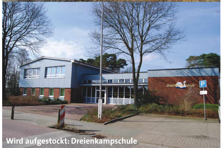
Neubau der Mensa an der Waldschule
